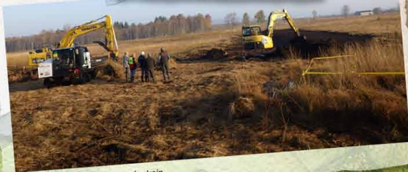
Travaux lourds de bouchage de drain.
