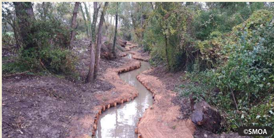
Opération de restauration hydromorphologique du ru des Planchettes à La Croix Saint-Ouen (amont immédiat de la confluence avec l'Oise) financée par l'AESN
