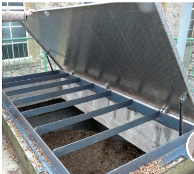
Les granulés ou les plaquettes sont stockés dans un silo de plusieurs mètres cubes, enterré ou non. Ces chaudières fonctionnent avec une vis sans fin ou un système d'aspiration qui transporte le combustible de la réserve à la chaudière. Il existe maintenant des transporteurs à vis horizontales coudées qui facilitent la configuration spatiale de l'installation. De la même manière, c'est une vis sans fin qui peut permettre l'évacuation des cendres.
