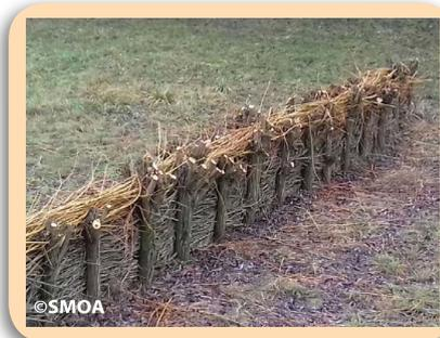
La fascine est un ouvrage léger qui permet le ralentissement des écoulements et le dépôt des sédiments entraînés. Elle permet aussi de limiter l'érosion sur plusieurs dizaines de mètres en aval en diminuant la vitesse de l'eau.
